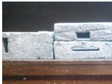
Gambar 7 Implementasi beton dengan cacat
