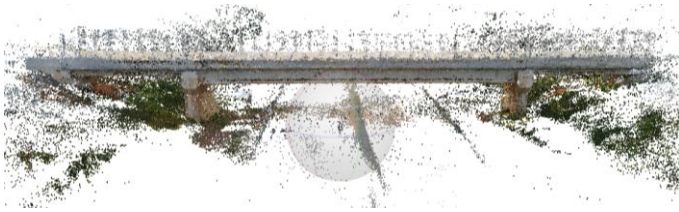
(b) tie point foto terestris area struktur overpass (tampak depan)
