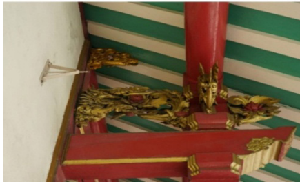
Gambar 13: Penyangga Atap Gereja dengan ornamen stilir naga (Pusat Dokumentasi Asitektural Jakarta, 2016)
