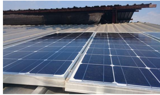
d. Panel surya 100 wp terpasang di atap kandang ayam pedaging milik kelompok Al Farouq
