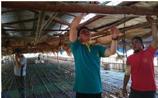
g. Pemasangan lampu LED untuk penerangan pada kandang ayam pedaging milik Al Farouq
