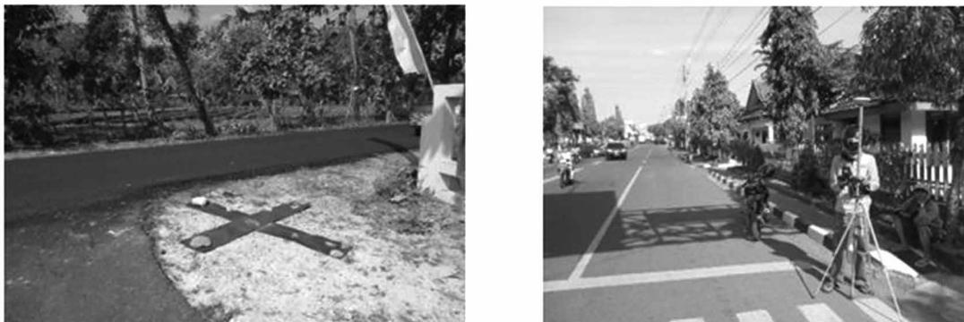
Gambar 3 Contoh *Benchmark* Berwarna Biru yang Terbuat dari Terpal (Kiri); Pengukuran Koodinat GCP Menggunakan GPS Geodetik
