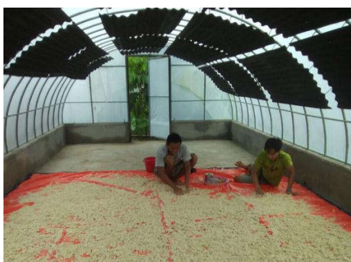
Gambar 11 Penampang dalam Pengering ERK dan Kegiatan Pengeringan
