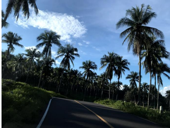
Foto 6. Kondisi Jalan Dari Kota Manado Ke Kawasan Sumber: survey lapangan, 2019
