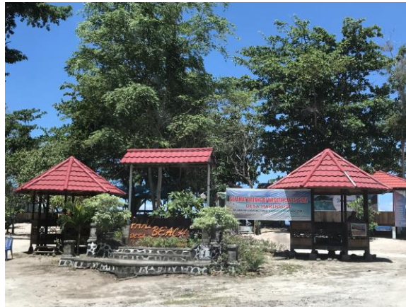
Foto 4. Kondisi Fasilitas Gazebo di Pantai Paal
