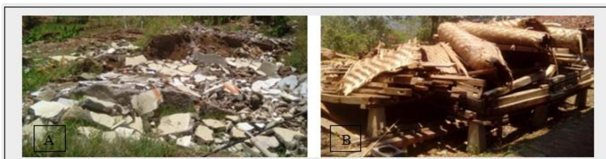
Keterangan : A = Rumah non panggung rusak parah; B = Rumah panggung dapat dipindahkan ke tempat aman
