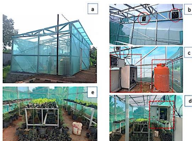
Gambar 8. Smart greenhouse dan sistem kendali, (a) struktur eksterior smart greenhouse, (b) kipas sirkulasi otomatis, (c) tangki air dan sistem pompa untuk irigasi, (d) panel kendali dengan perangkat elektronik, (e) area budidaya tanaman di dalam greenhouse.
