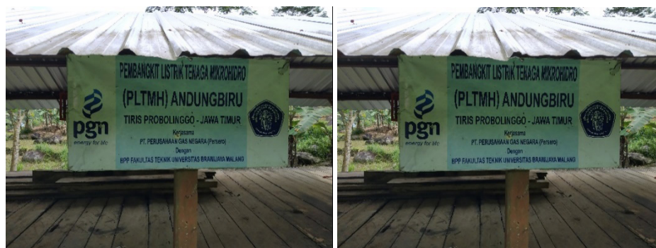
Gambar 4 Bangunan Unit Dua PLTMH
