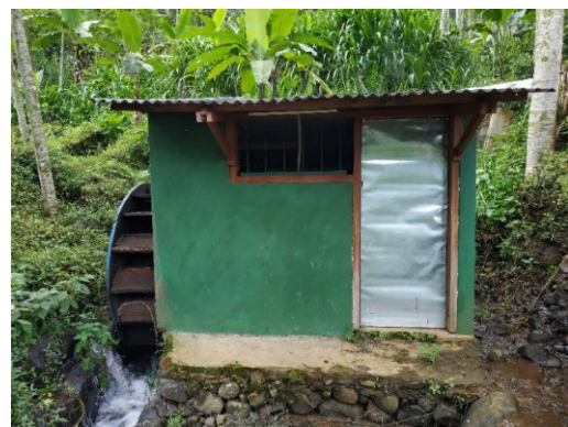
Gambar 2 Lang-Baling (Bangunan Awal PLTMH)
