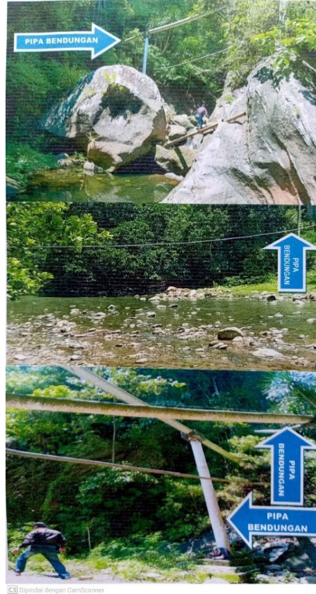
Gambar 5 Pipa Bendungan Aliran Sungai Lembang Mombi
