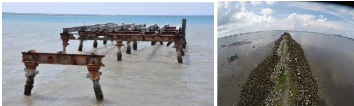
Gambar 3. Foto struktur dermaga Pelabuhan Boom. (Sumber: Berkas Rekomendasi KCB Pelabuhan Boom).
