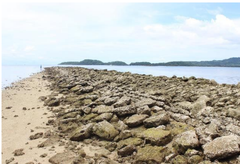
Gambar 5. Foto struktur dam pemecah ombak (Sumber: Berkas Rekomendasi KCB Pelabuhan Boom).
