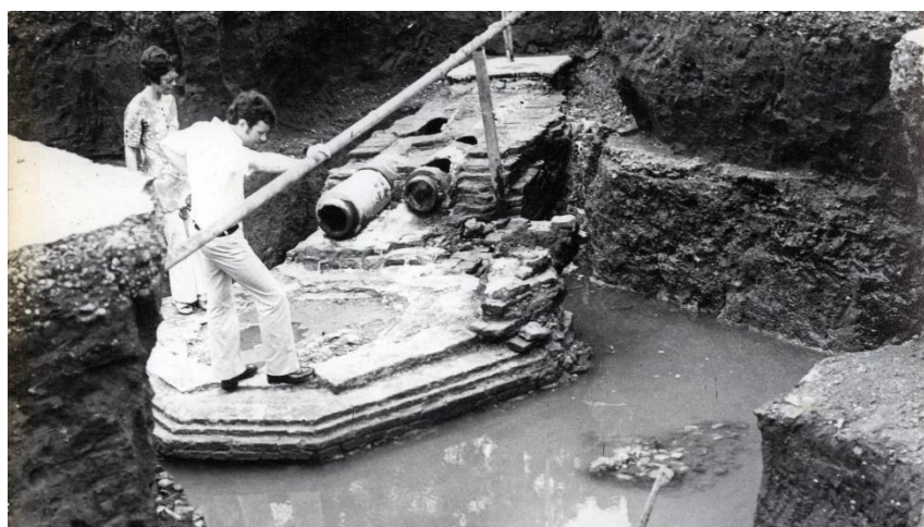
Gambar 5. Temuan fondasi fontein dan pipa air bersih tahun 1973 (Sumber: Dinas Museum Kesenjarian DKI Jakarta)
