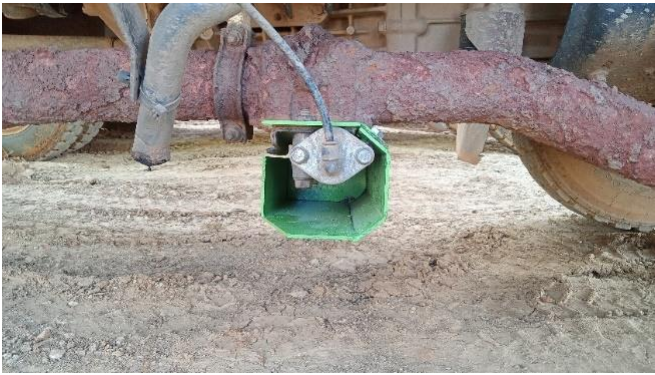
Gambar 4. Pemasangan cover pada unit
