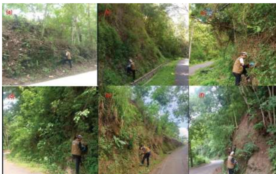
Gambar 3.1 dokumentasi kondisi lereng dan pengukuran di lapangan. (a) pengukuran di STA 1, (b) pengukuran di STA 2, (c) pengukuran di STA 3, (d) pengukuran di STA 4, (e) pengukuran di STA 5, (f) pengukuran di STA 6.
