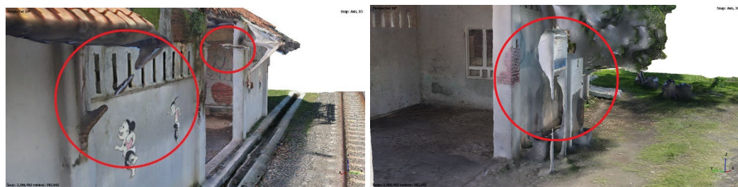
Gambar 11. Kesalahan pemodelan mesh pada penyangga atap stasiun (kiri) dan kesalahan bagian belakang plang penanda (kanan) akibat kurangnya foto yang diambil pada area tersebut
