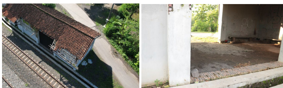
Gambar 5. Atap bangunan (kiri) dan interior bangunan (kanan)
