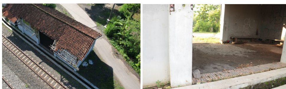
Gambar 5. Atap bangunan (kiri) dan interior bangunan (kanan)
