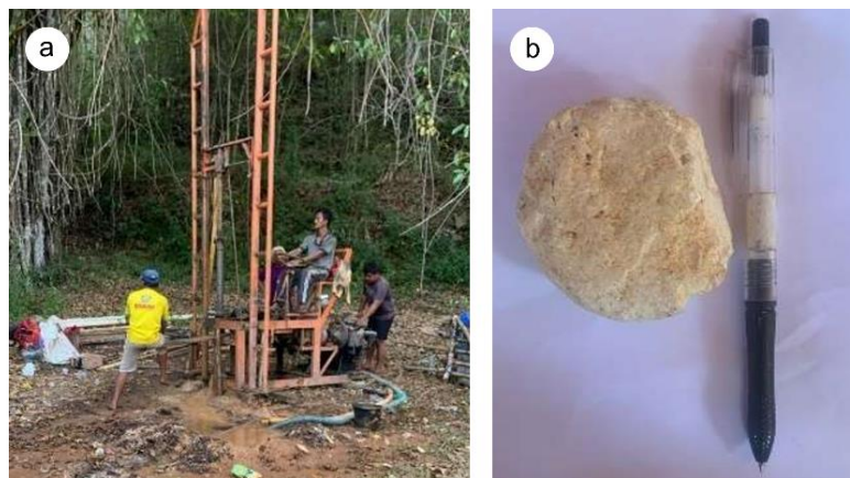
Gambar 5. (a) Tindakan pengeboran sumur di titik A; (b) Sampel batuan titik A di kedalaman sekitar 15 meter
